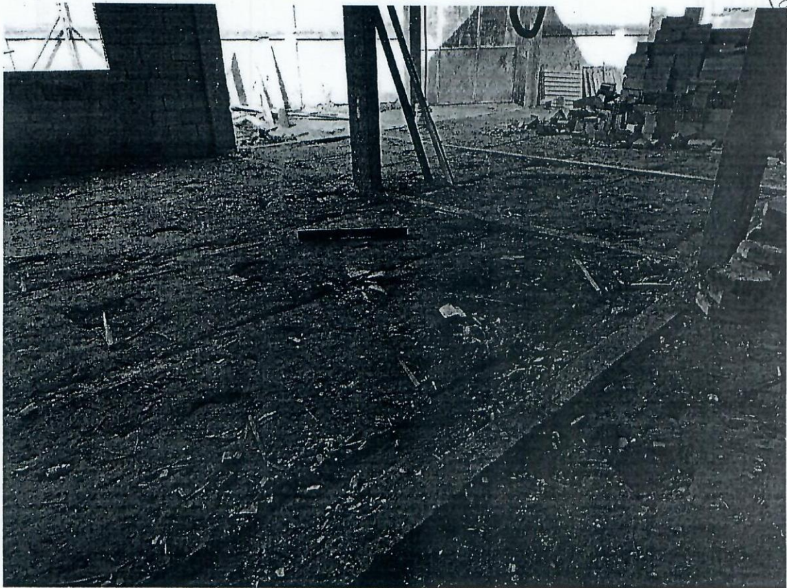
FOTO 7 – REFORMA E AMPLIAÇÃO EMEIF SÃO MARCOS
