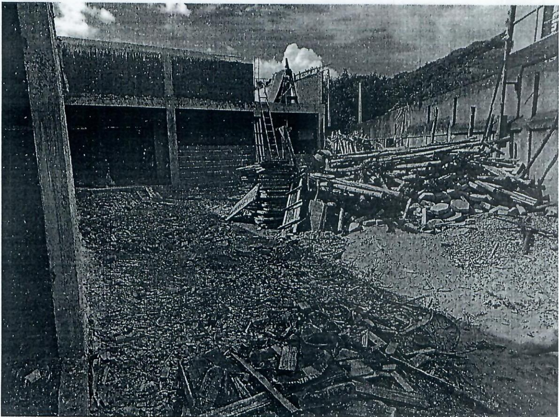
FOTO 4 – REFORMA E AMPLIAÇÃO EMEIF SÃO MARCOS
