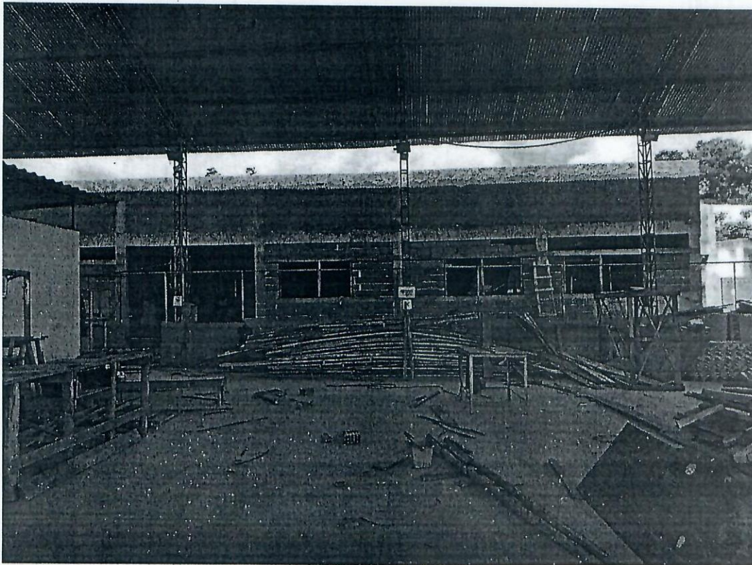
FOTO 1 – REFORMA E AMPLIAÇÃO EMEIF SÃO MARCOS
