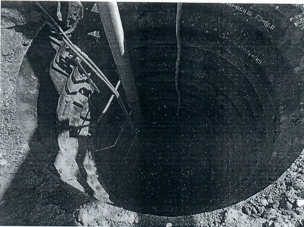
FOTO 12 – PV EXECUTADO DN120
