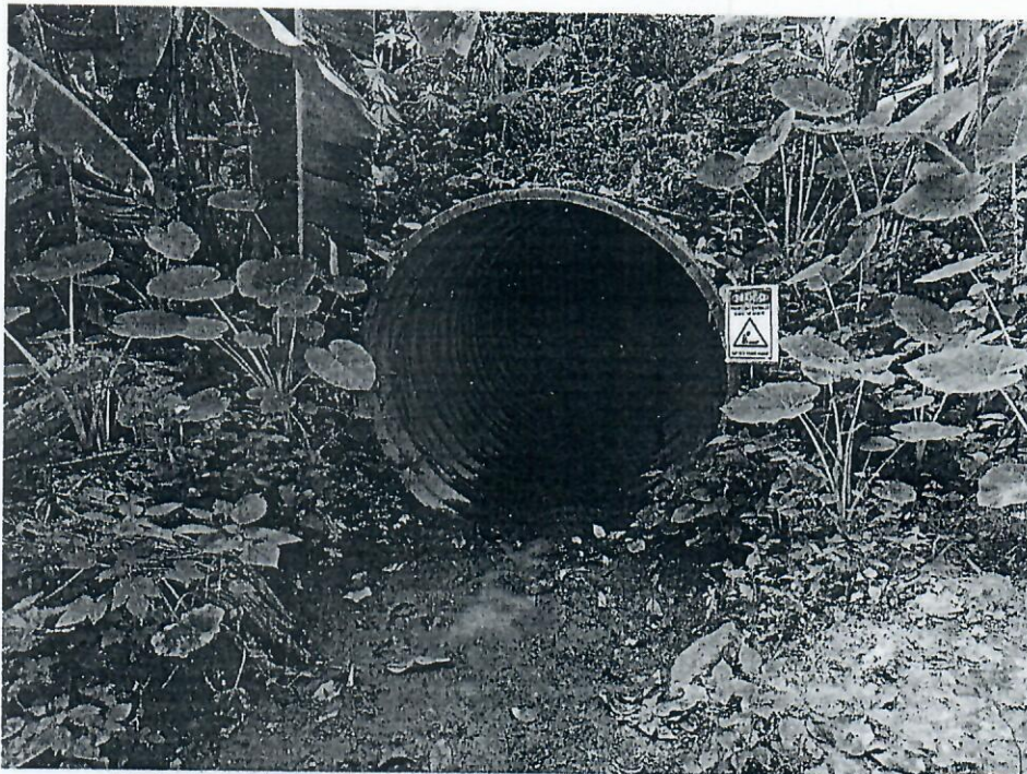
FOTO 14 – TUNNEL EXISTENTE – EXECUTADO EM CONTRATO ANTERIOR
