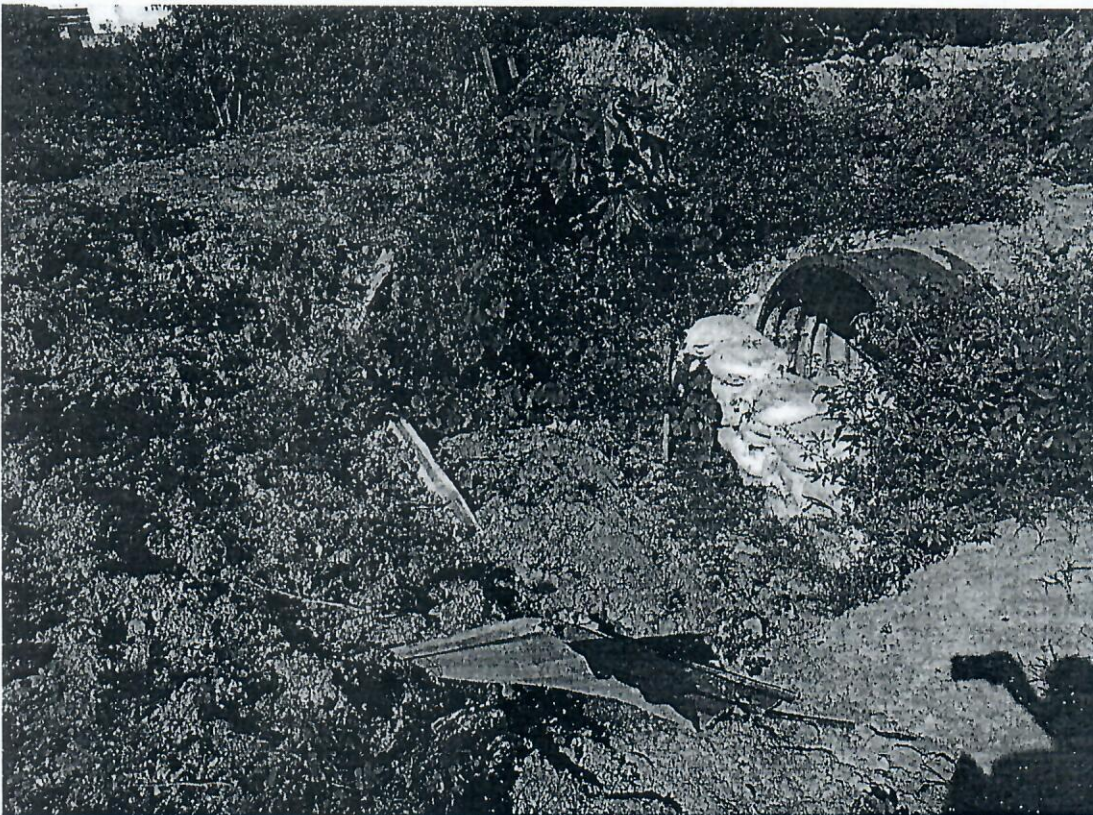
FOTO 10 – TUNNEL LINER - TRECHO EXECUTADO
