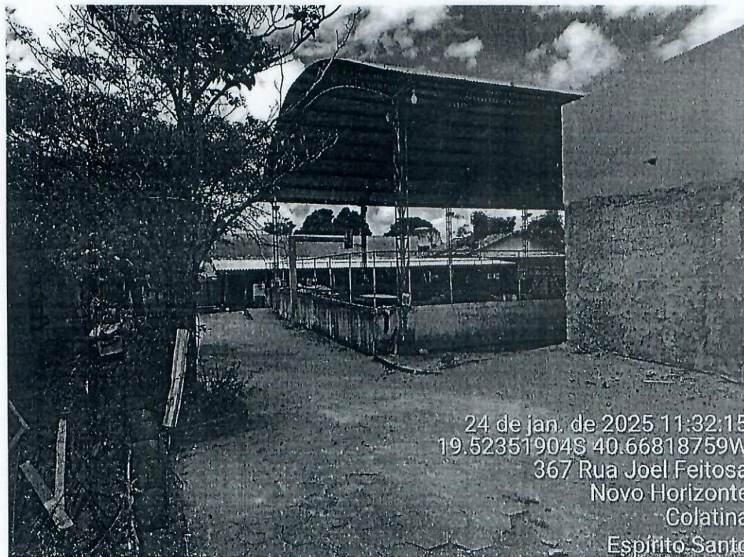
FOTO 2 – REFORMA E AMPLIAÇÃO EMEIF SÃO MARCOS
