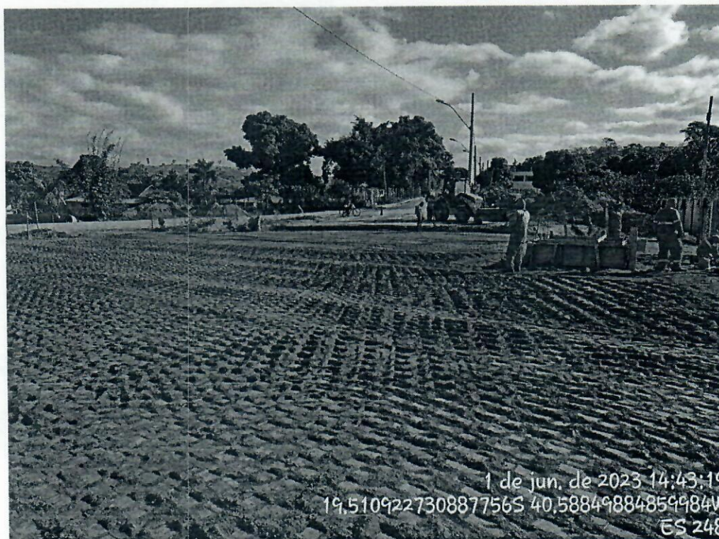
Foto 02: Conclusão dos serviços na Rodovia ES 248, entrada da comunidade afetada.
