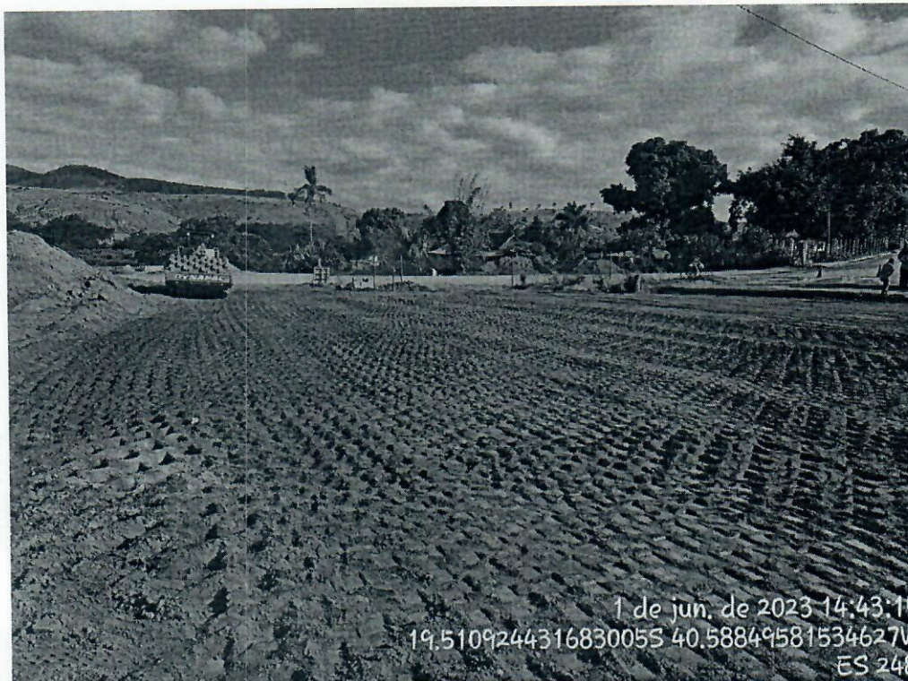
Foto 01: Conclusão dos serviços na Rodovia ES 248, entrada da comunidade afetada.
