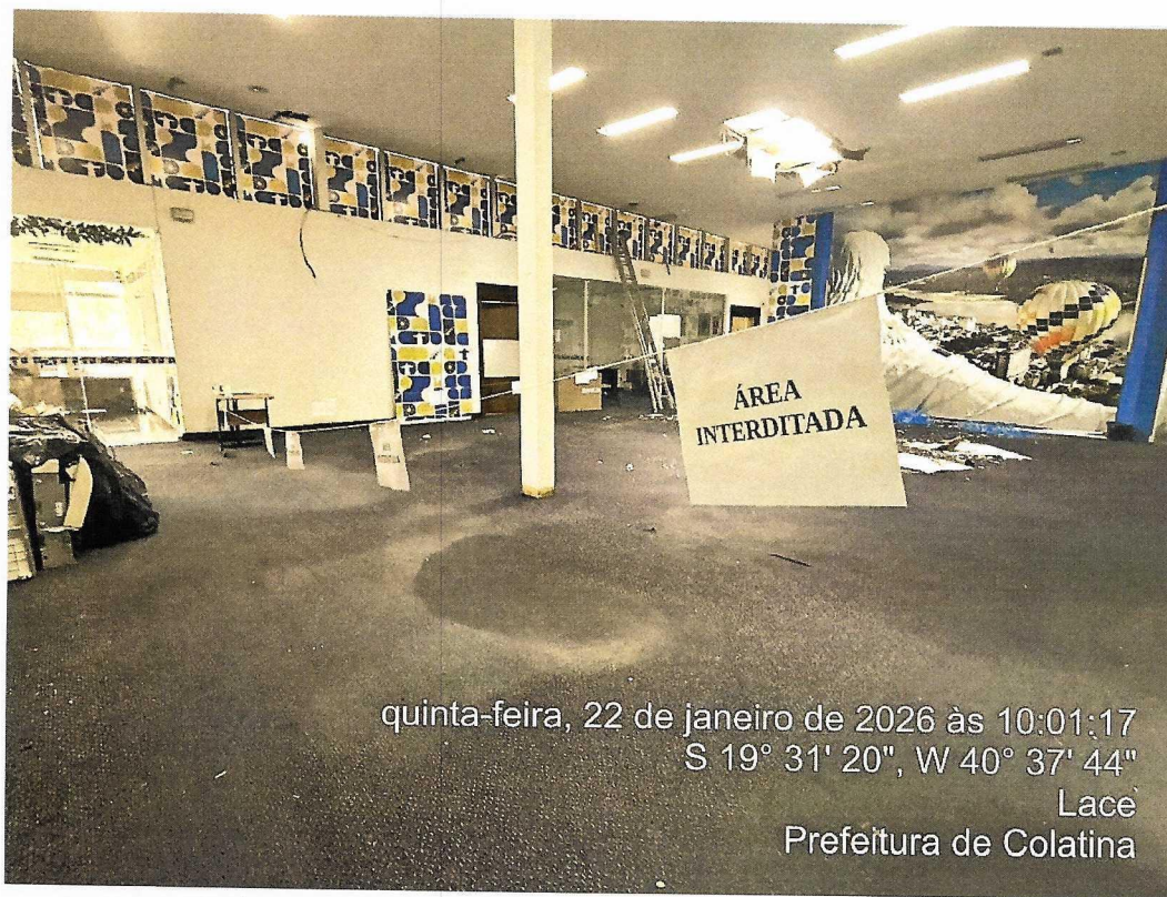
Figura 09 – Vista de área sinalizada com interdição.
