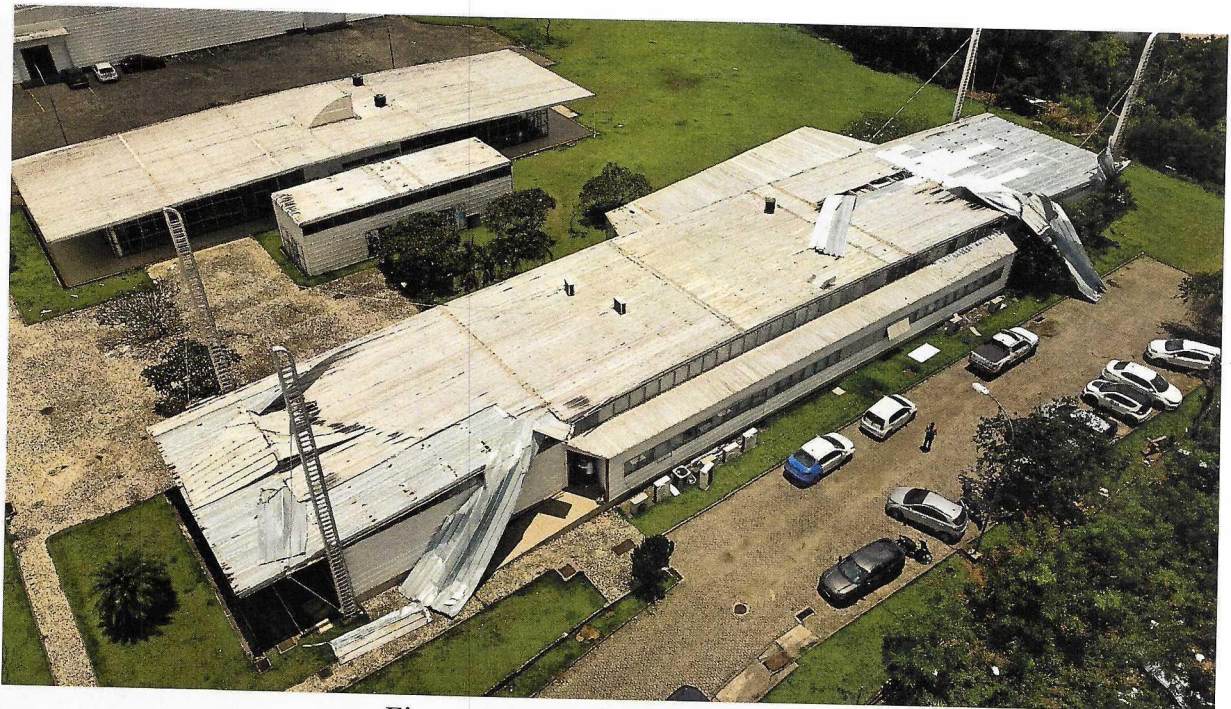
Figura 01 – Vista aérea do imóvel.
