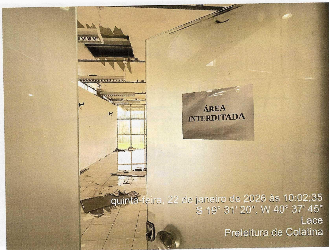
Figura 07 – Vista de área sinalizada com interdição.
