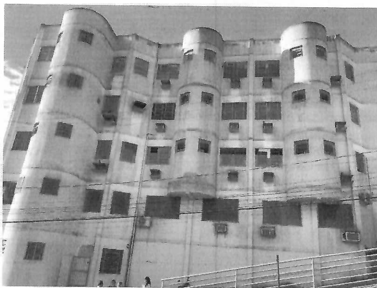
Figura 1: Imóvel Público Municipal - Cedido à Santa Casa
