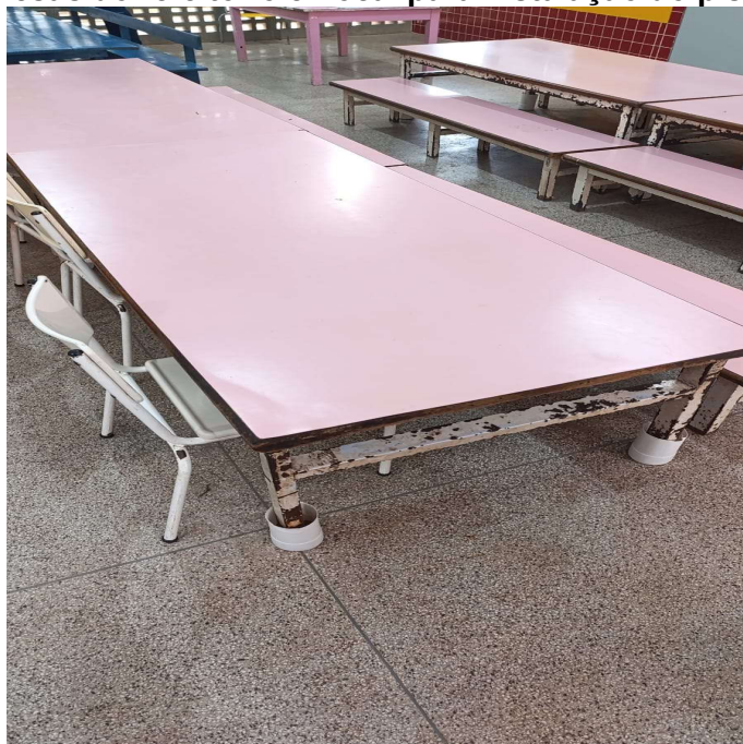
Mesas do refeitório e Local para instalação do piso.
